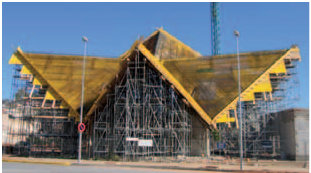
Cimbra BRIO, en el apeo de losa de cubierta de la Iglesia de la Sagrada Familia en Alzira, Valencia, España
