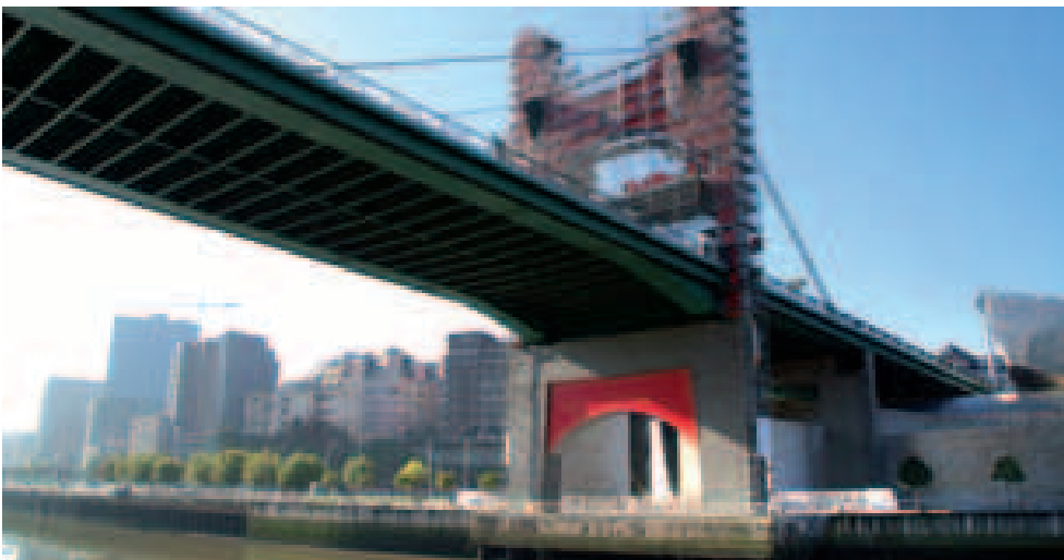
Restauración del puente de La Salve, Bilbao, España
