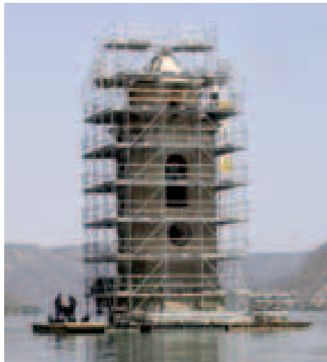
Montaje en antigua torre en el Embalse de Fayón, Zaragoza, España
