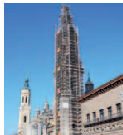
Restauración de la Basílica del Pilar, Zaragoza, España
